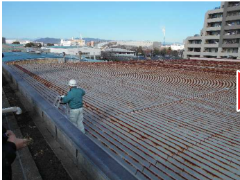
▲ 屋根全体がサビてしまった倉庫の屋上/一部では亀裂などが原因による雨漏りも見られていました。
