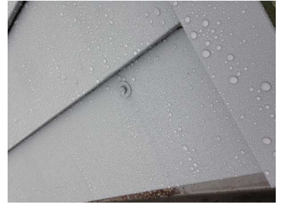
▲ 鉄板屋根にラバーロックを施工。その後降雨した直後の状況。雨水が塗膜に弾かれ、水玉状になり、素地への侵入を防止します。
