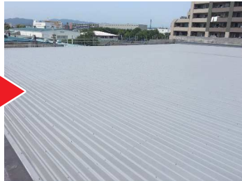
▲ 屋根を全面施工。防錆効果だけでなく、撥水・防水効果も得られ、雨漏りもストップ。遮熱材との併用で遮熱効果も追加可能です。
