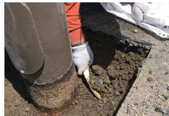
▲ 設置から期間が経過した鉄柱。雨水や犬の尿でサビ/腐食が進行。そのまま放置すれば、倒壊の危険も...
