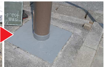
▲ サビキラーPRO RS + BAN-ZI AIDとの併用により、サビの原因となる地中への雨水やペットの尿の侵入を完全にシャットアウト。倒壊の危険を回避&耐用年数の延長も実現。
