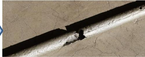
錆びているものは、先にサビキラープロを塗装し錆の進行を止めます。
